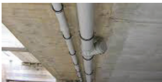
Passaggio impianti a soffitto, a vista
